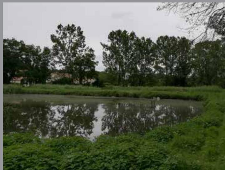
Le lagunage nécessite une mise en conformité afin d'améliorer l'efficacité du traitement des eaux usées avant rejet dans le milieu naturel. La question de sa mise en conformité ou l'orientation vers un autre système d'assainissement était donc posée.
