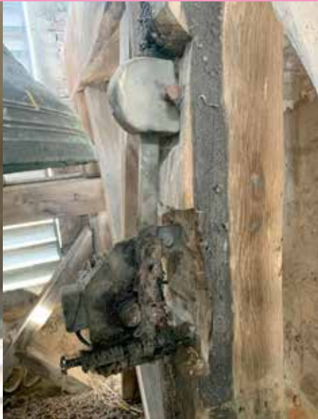
Moteur de tintement de la grosse cloche
